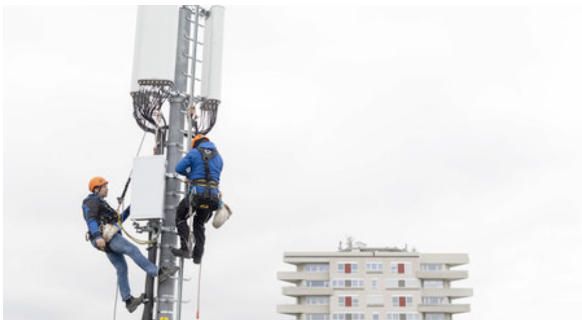
Deux employés de l'entreprise Axians installent une antenne 5G dans le canton de Genève, le 10 avril 2020. — © Keystone/Martial Trezzini)
